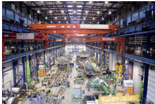
80 Meter lang, 40 Meter breit und 35 Meter hoch: Das Mega-Testzentrum am Siemens-Standort in Duisburg-Hochfeld. Hier erlebten die Gäste die Montage und Erprobung großer Verdichterstränge mit bis zu 700 Tonnen Gesamtgewicht. Foto: Siemens AG.
