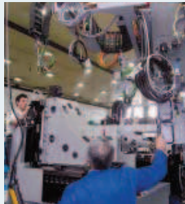
Vorinstalliert: Vorgefertigte hybride Baugruppen revolutionieren den Schaltschrankbau Bild: Schweiger
